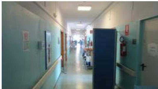
Il collegamento dei piani avviene mediante due vani scala, uno interno al reparto e uno comune a tutta la struttura del P.O. L'accesso avviene dal corridoio principale del piano mediante porte tagliafuoco a battente normalmente chiuse.
