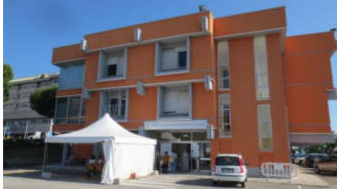
La Palazzina con struttura in c.a., è costituita da tre piani fuori terra (terra, primo e secondo) ed un piano copertura, collegati tra loro mediante due vani scala interno di cui uno compartimentato.
