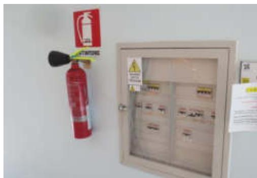
Tutti i quadri sono dotati di interruttori differenziali contro i contatti diretti ed indiretti e magnetotermici per il sezionamento delle utenze.
