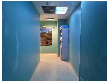
corridoio del bunker
